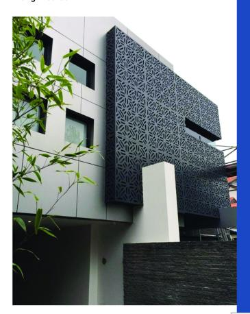
جی اف آرسی یکی از متریال های محبوب و جدید نمای ساختمان است که با ترکیب سیلیس، سنگدانه، سیمان های خاص، الیاف شیشه و سایر افزودنی ها تحت تکنولوژی خاص تولید می گردد. جی اف آرسی متریالی کاملا سفارشی است و به صورت پنـل های پیـش ساخته درنمای ساختمان به کارمی رود. بـا ایـن متریـال مـی تـوان انـواع پنـل هـای پیـش ساخته بتنـی را در ابعـاد و انـدازه هـای مختلف و در طرح و قطعات خاص سفارشی تولید کرد.
