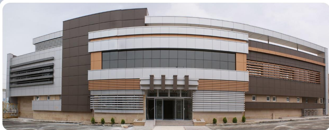
پروژه استخر نور آدرس: تهران، شهرک غرب سیستم اجرایی: UPVC سیندژ
