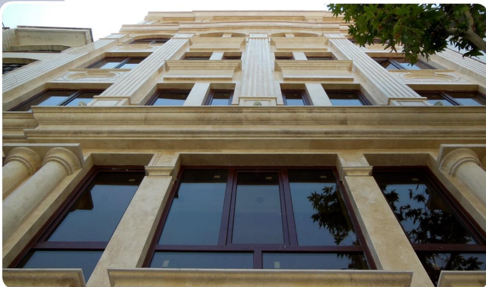
پروژه آقای بقایی آدرس: تهران، تهرانپارس، خیابان ۱۷۶ غربی سیستم اجرایی: UPVC وینتک، بیرون لمینت
