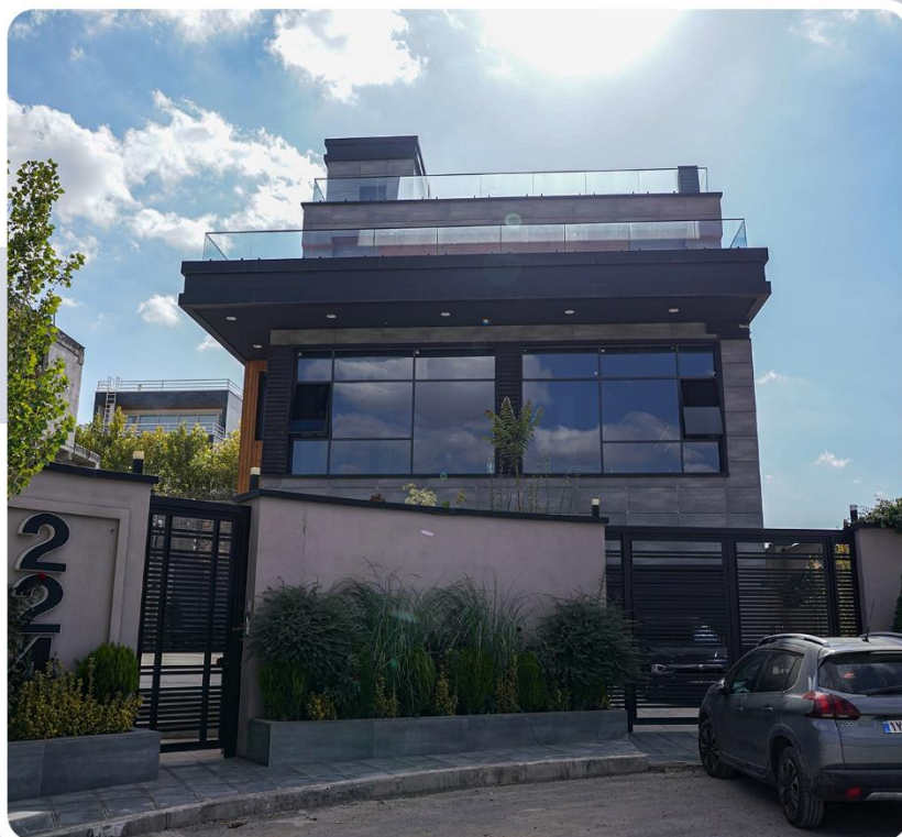
پروژه آقای مختاری آدرس: دماوند، شهرک هشت بهشت سیستم اجرایی: کرتین وال، لیفت دفنی، نرمال سری ۶۵ فلت
