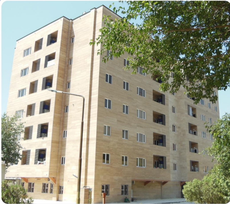
پروژه مسکونی شهید کلاهدوز (شرکت پایدارسازه) آدرس: تهران، اتوبان بسیج شمال، بعد از بلوار هجرت سیستم اجرایی: UPVC سیندر
