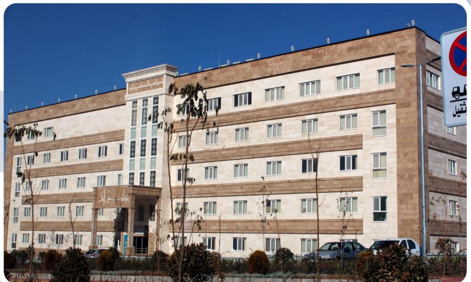
پروژه ساختمان بقیه الله (شرکت پایدارسازه) آدرس: تهران، اتوبان شهید دوران، میدان شهید مهتدی سیستم اجرایی: UPVC ویستابست
