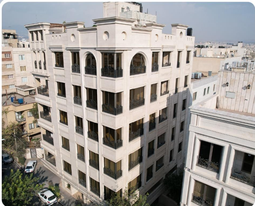
پروژه آقای کیارستمی آدرس: تهران، نارمک، میدان ۶۰ سیستم اجرایی: ترمال سری ۶۵ مستر
